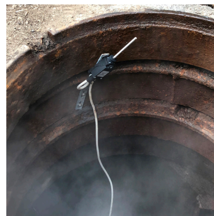
Рис. 7. Дополнительное подключение к модему PROMODEM GSM-125.00М датчика открытия люка PROMODEM 942.12: надежный рабочий ход удлиненного пружинного триггера исключает ложные срабатывания при проезде машин или неаккуратном монтаже люка
