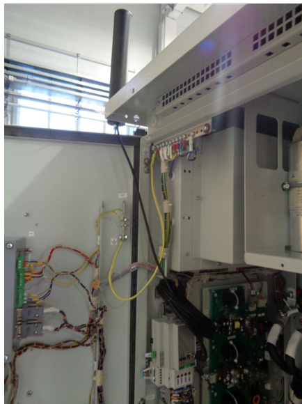
Рис. 1. Подключение контроллера АСУ ТП (RS-485) и измерителя входного напряжения (RS-232) к 2-интерфейсному модему PROMODEM GSM-125.89M со встроенным аккумулятором
