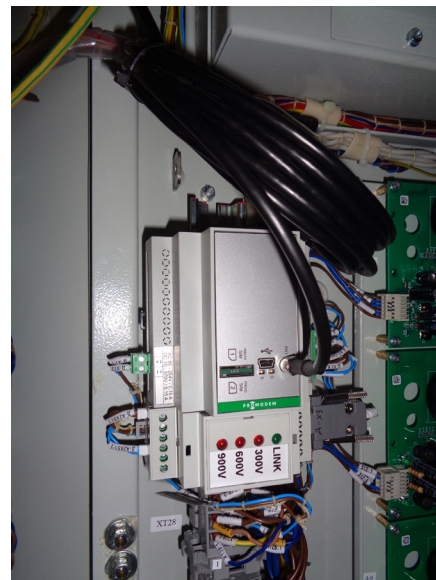
Рис. 1. Подключение контроллера АСУ ТП (RS-485) и измерителя входного напряжения (RS-232) к 2-интерфейсному модему PROMODEM GSM-125.89M со встроенным аккумулятором
